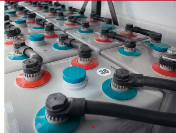
Batterien als stationäre Speicher sind Teil des Micro Smart Grids. | Batteries, as stationary storage, are part of the micro smart grid.
